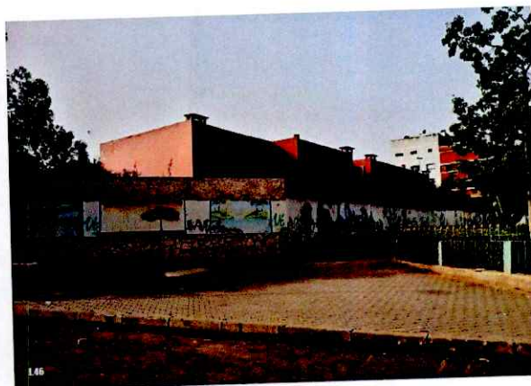
I.45: Logements collectifs, Bernoussi Ouest.
