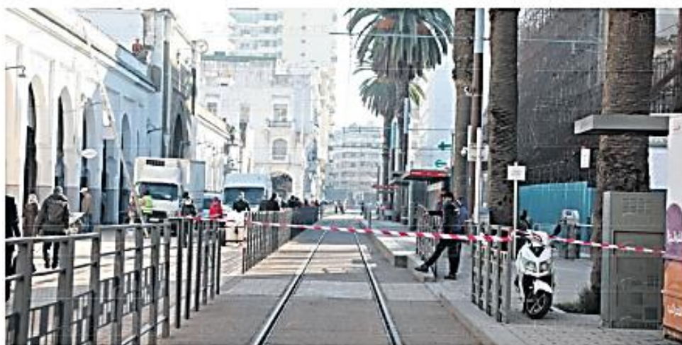
Fermé et abandonné depuis 1989, l'hôtel Lincoln s'est effondré à plusieurs reprises suite à de fortes pluies. Les échafaudages, censés retenir la structure vétuste, s'effondrent à leur tour (Ph. F. Alnasser)
